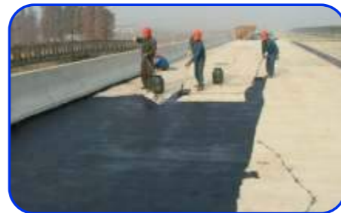
2. Brush Substrate Treatment Primer
